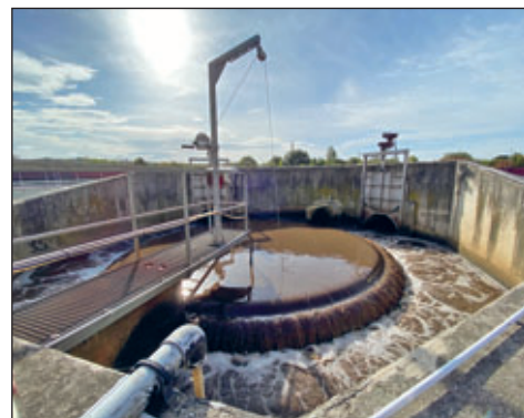
Zuführung von Eisen(III)-chlorid im Verteilbauwerk Nachklärbecken
