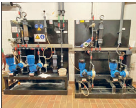
Dosieranlage für Natriumaluminat und Eisen(III)-chlorid mit Dosierpumpen
