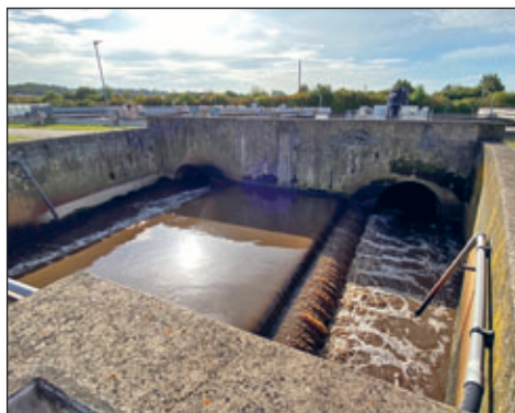
Zuführung von Natriumaluminat Verteilbauwerk Belebungsbecken
